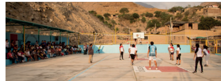
Renovación de losa deportiva en barrio Chinguión: Este proyecto de mejoramiento de espacio deportivo comprende el resane de la losa deportiva, habilitación de tableros de basquetbol, construcción de servicios higiénicos y pintado de graderías.
